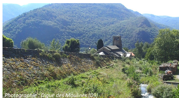
Photographie : Digue des Moulins (09)
