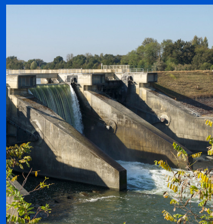
Barrage de Manciès (31)
