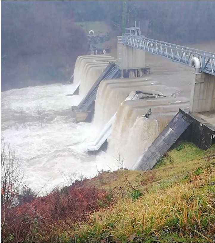
Barrage de Record sur l'Agout (81)
